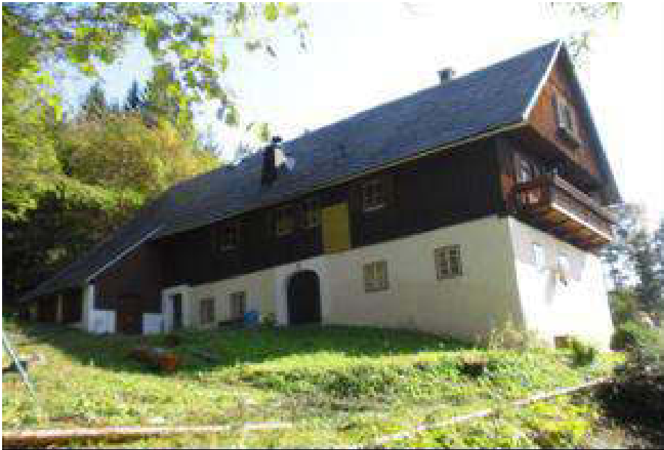
Altbestand vor Beginn der Baumaßnahmen
