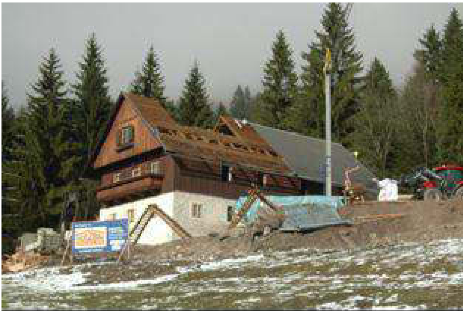
Abbrucharbeiten des alten Dachstuhles
