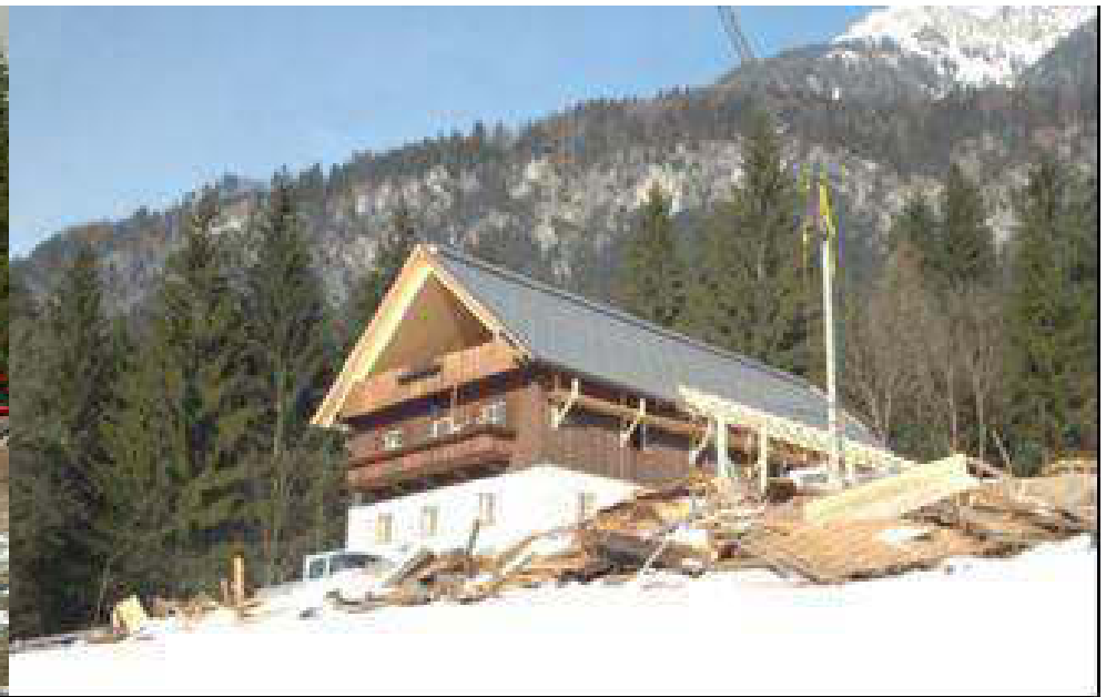
Neuer Dachstuhl samt neuer Dachdeckung
